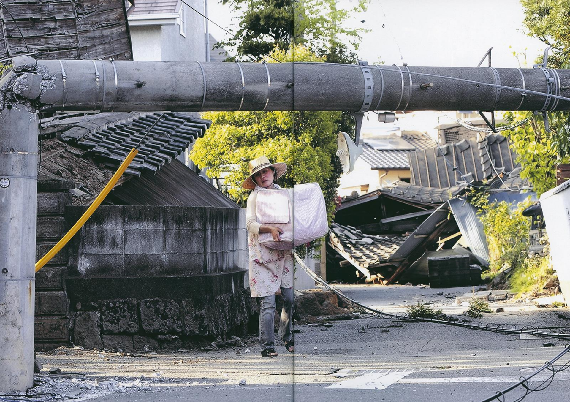
折れた電柱の下で、大きな荷物を運ぶ女性＝15日午後5時15分ごろ、益城町
